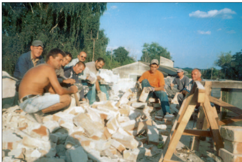
Rekonštrukciu hlavnej budovy RS sme začali búracími prácami
