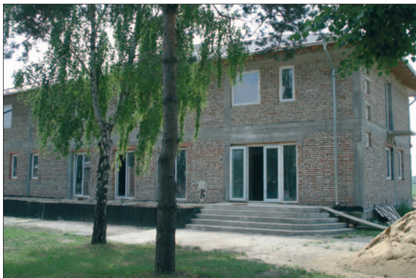
Zrekonštruovaná budova Resocializačného strediska vo Veľkých Kosihách, tesne pred dokončením
